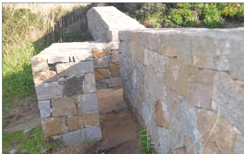
Photo 38. Mur en pierres empêchant l'accès des véhicules au site Natura 2000 par le sud. Seuls les piétons peuvent accéder au site Natura 2000, par suite de ce mur en chicane (mur vu de l'ouest, 29 janvier 2017).
