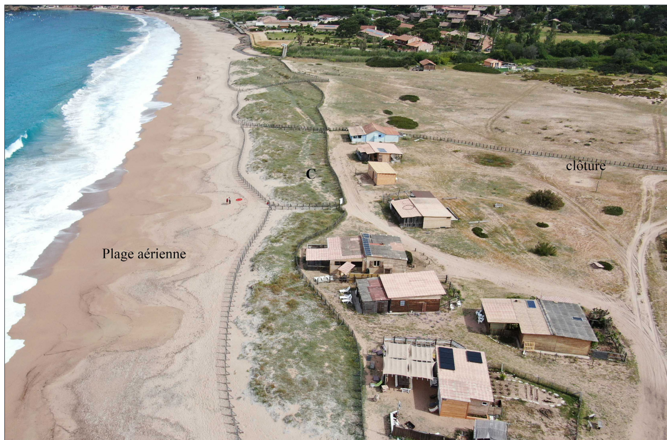
Figure 6. Ganivelles dans la partie antérieure de la basse terrasse et longue clôture de direction est-ouest. C : ancien passage en voie de végétalisation. (Photo prise le 18 mai 2021 avec un drone par P. Spinosi).
