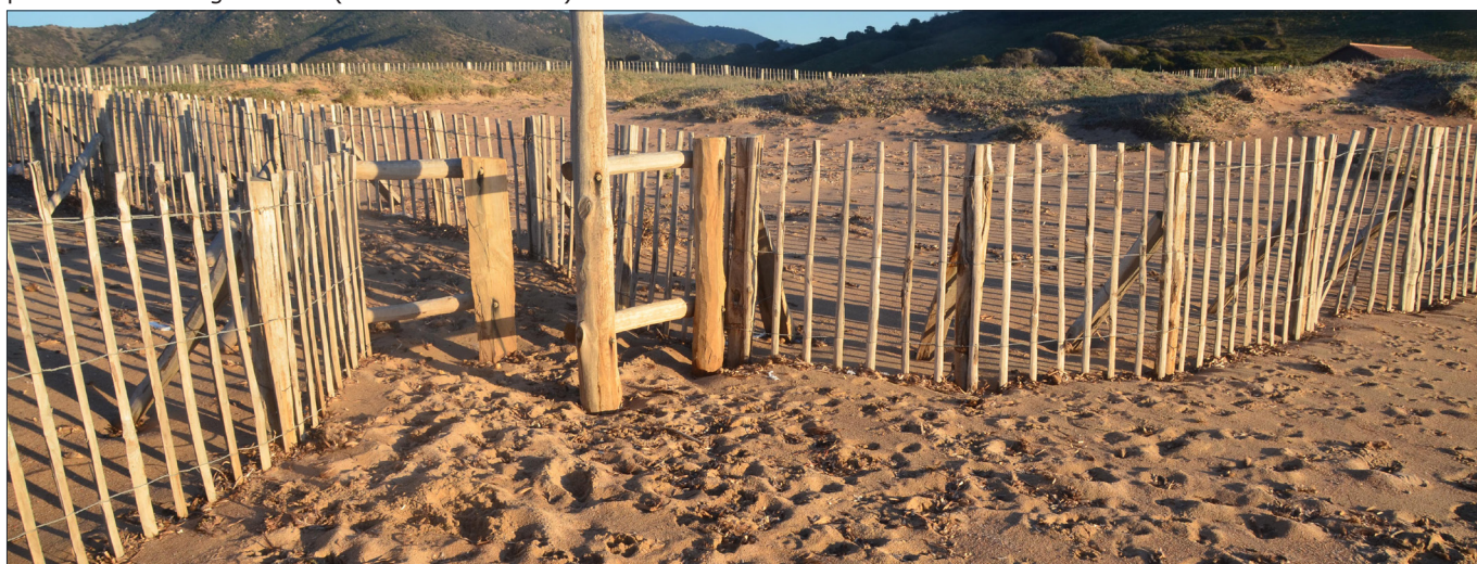
Photo 34. Autre dispositif pour empêcher la circulation des petits véhicules motorisés, au débouché sur la plage aérienne d'un passage pour piétons entre les ganivelles (20 décembre 2017).
